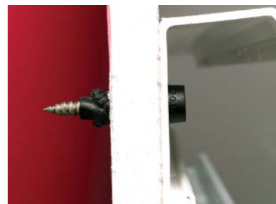
4. Sujeción por contracción del material
