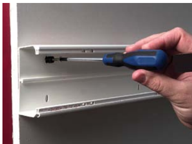
2. Clavar con ayuda de martillo y destornillador
