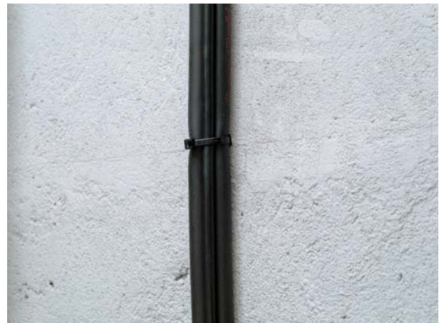
Tubos de climatización
