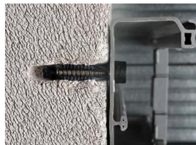
3. Sujeción por expansión del material
